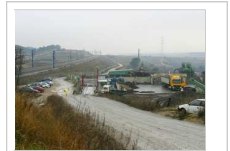
Les instal·lacions de Fragsa que continua al mateix lloc malgrat els plens judicials. Foto: EL PUNT.
