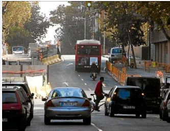
Tram del carrer d'Espronceda amb els dos carrils oberts després d'acabar el túnel de l'AVE, ahir. Foto: joan puig
